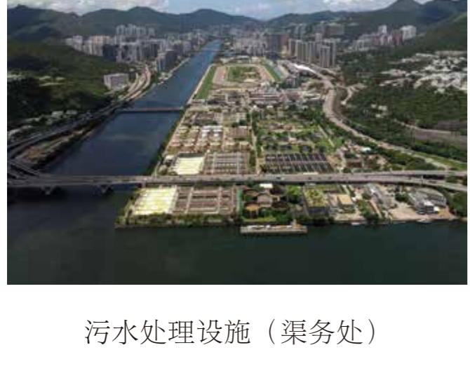
污水处理设施 (渠务处)
